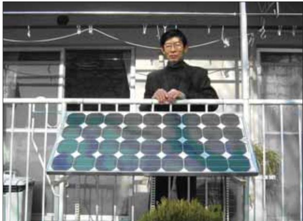
ダに設置し、昼間に発電した電力をバッテリーに蓄電し、テレビの電源として活用している。2002年12月の設置以来、大きなトラブルもなく順調に発電しており、推定累積発電量は180kWhになる。冬は15分から25分、夏は80～180分テレビを見ることが可能とのこと（図27）。
