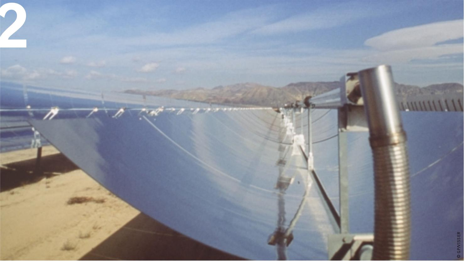
集光型太陽熱発電（CSP）システム。米国カリフォルニア州ダゲットのソーラーファーム。
