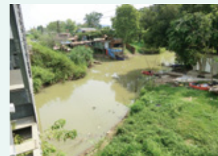
クラマン水門建設予定地の様子(写真: JICA)
