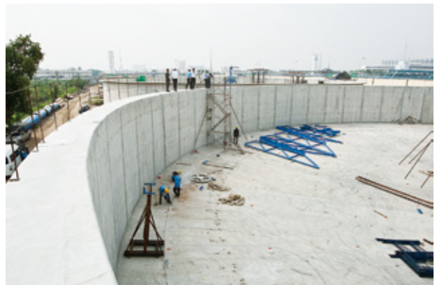
タイのバンコク首都圏のバンケン浄水場工事現場(写真:久野真一/JICA)
