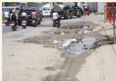
路面に大きな穴が開くことで、渋滞や事故を引き起こす原因となっている (写真：(株)愛亀)
