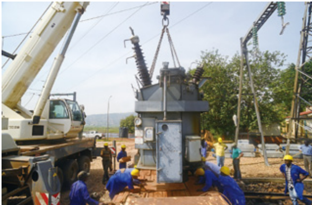
ルワンダ・キガリの変電施設および配電網建設現場(写真:久野武志/JICA)
