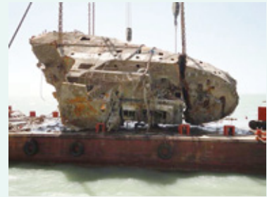
港湾整備計画での沈没船除去(写真: JICA)
