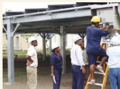
パワーコンディショナーの点検方法を確認する現地スタッフたち(写真: (有) 沖縄小堀電機)
