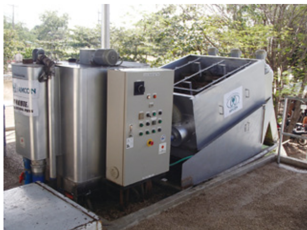
1時間に10トンの汚泥処理能力を持つ脱水機。省電力・省水量、運転管理の容易さが特徴で、24時間無人運転が可能(写真:アムコン(株))
