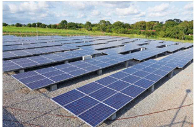
ガーナ・アクラのガーナ大学構内に日本の無償資金協力で造られた大規模なソーラーパネル施設(写真:久野武志/JICA)
