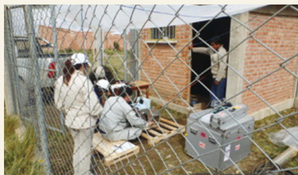
現地で行われたデモンストレーションの様子(写真：(株)レアックス)
