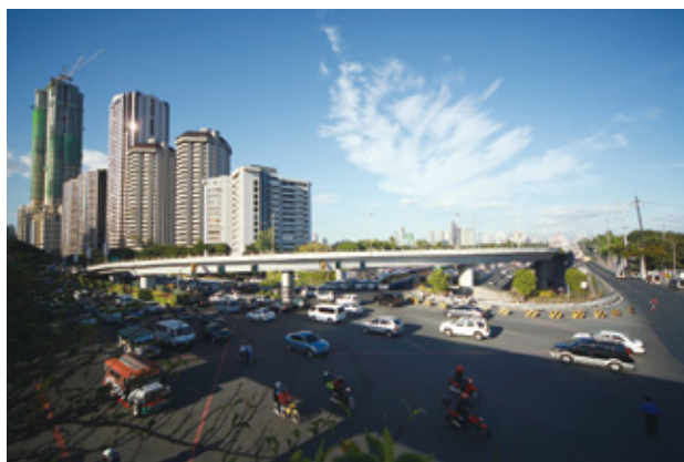
フィリピン・「メトロマニラ立体交差建設事業」においてマカティ市内のビジネス地区に建設された立体交差。交通渋滞の緩和に貢献している(写真: ハービー・タバン)
