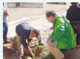
ヤムルーフ水道公社(YWC)職員による配水管の漏水調査
