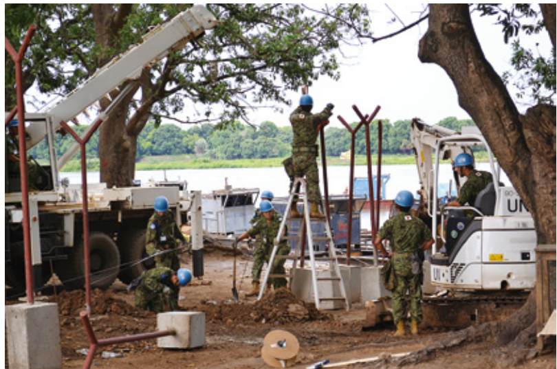
南スーダンの首都ジュバ市内のジュバ河川港において安全確保のための防護柵を設置している様子 (写真：防衛省)
