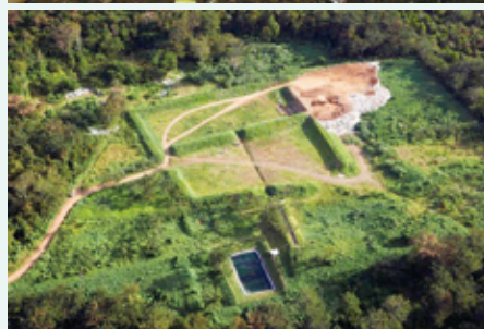
サモアのごみ処理場。見違えるほど改善された (上は改善前、下は改善後) (写真：JICA)
