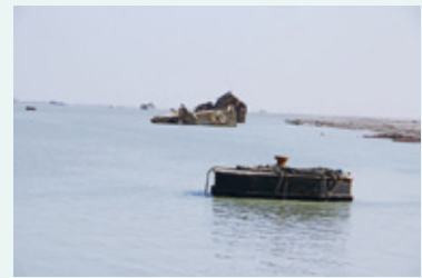
プロジェクトサイトのバース拡張予定地(写真: JICA)
