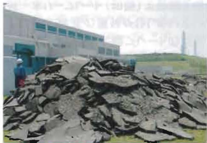
●中越沖地震(2007年7月16日)による被災後の柏崎刈羽原発構内。割がされたアスファルトの山。写真提供:サイエンスライター・田中三彦
