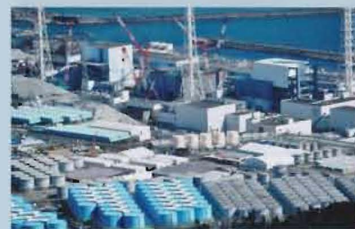
福島第一原発の構内に設置された汚染水を貯めるタンク
